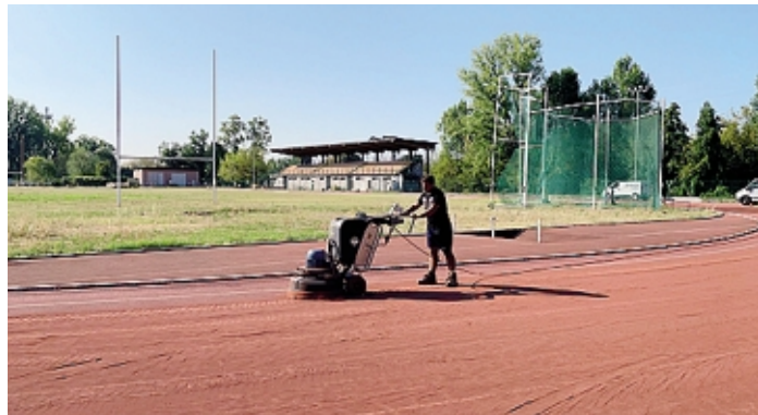
Lavori di riqualificazione degli impianti alla pista di atletica della Faustina
