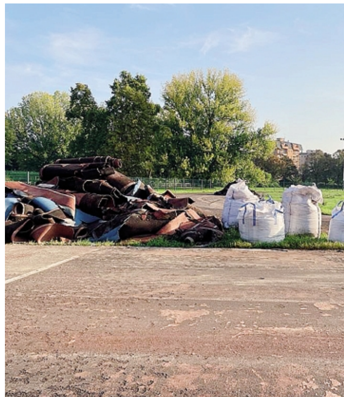
Pista di atletica alla Faustina, rimosso il fondo e i resti ammassati in sacchi
